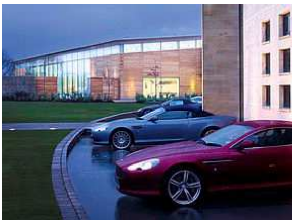
Spezialauftrag in England: Aston Martin beauftragte Holzbau Saurer 2007 mit dem schnellstmöglichen Bau eines neuen Designcenters. Für die extravaganten Gebäude
