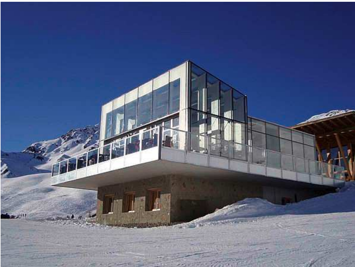
Holz und Glas in funktionaler Symbiose: Der vordere Gebäudekubus der Skihütte Masner in Serfaus lässt sich über den hinteren Gebäudeteil verschieben, so können Gäste die Bergluft an schönen Tagen noch länger genießen.
