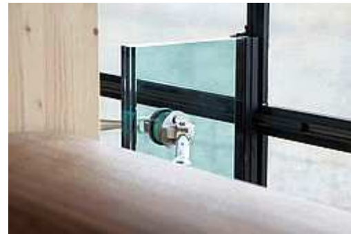
Gefinkelttes Anschlussdetail: Weil man keinen Glaser fand, der 8m hohe Glasfassaden herstellen konnte, musste für Aston Martin gestückelt werden – der Anschluss wurde über eine Glasbrücke, die mit der Hauptkonstruktion verbunden wurde, hergestellt.
