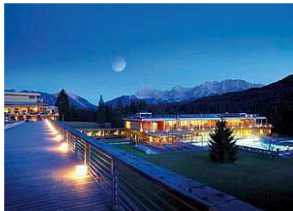
Höchstgradig vorgefertigt: Das Team von Holzbau Saurer hat beim Hotelprojekt in Kranzbach 2.500 m 2 Nutzfläche für Hotelzimmer und ein Badehaus geschaffen – das komplette Gebäude
