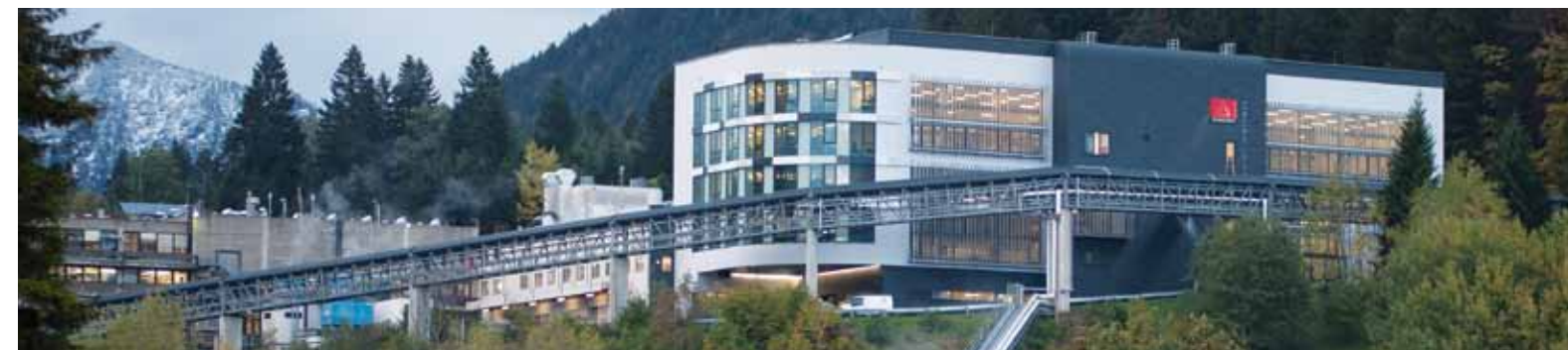
In den Fels gezimmert: das Gebäude B68 der Ceratizit Austria GmbH erforderte Teamwork und Höchstleistung. High-Tech-Industriearchitektur vom Feinsten.
