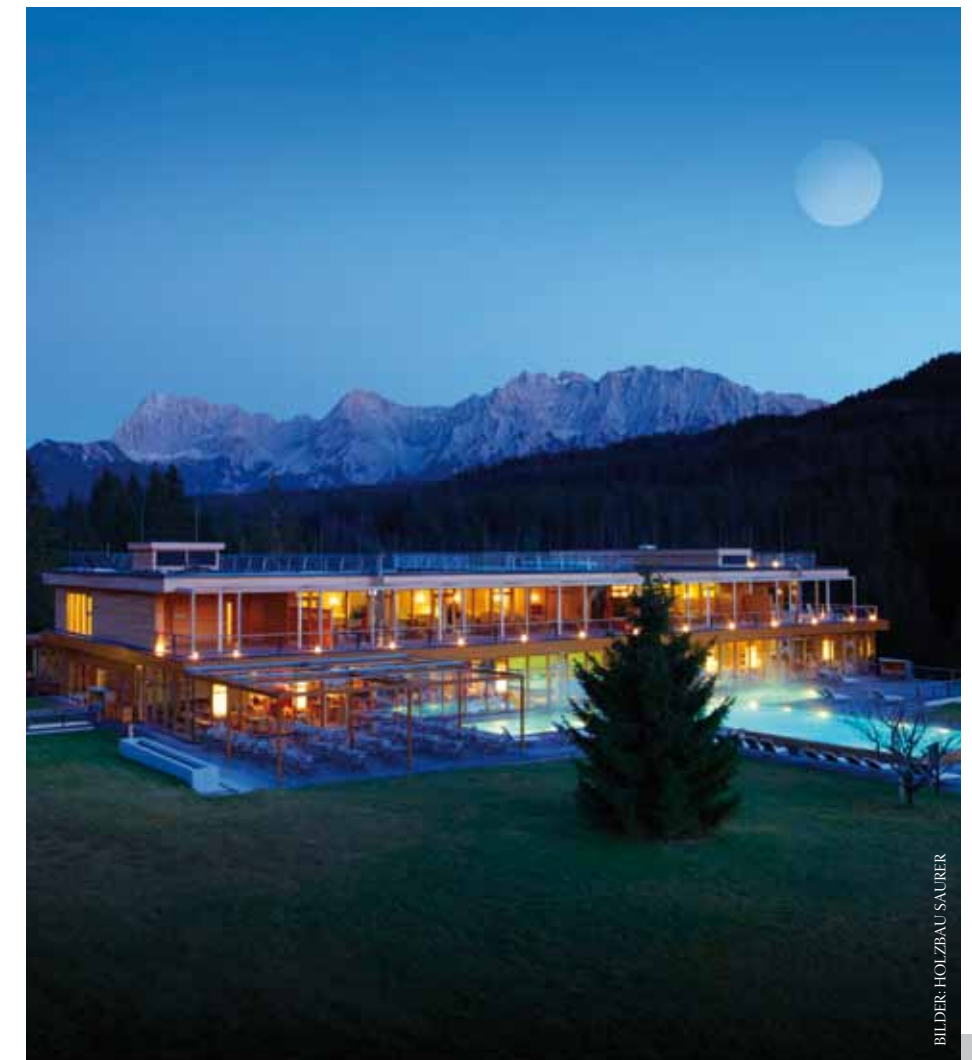
Aufstockung des Hotel Kranzbach bei Garmisch. Höchstgradig vorgefertigt. 2500 m 2 Nutzfläche für Hotelzimmer und Badehaus in 28 Tagen schlüsselfertig. Logistik und Teamwork vom Feinsten.
